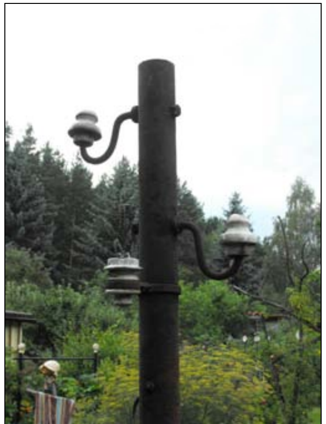
Der historische Strommast
