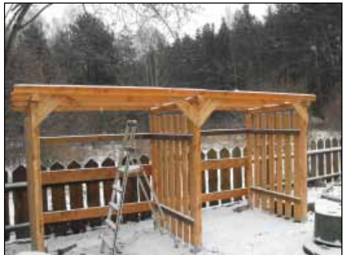
Schnee behindert die Dacharbeit
