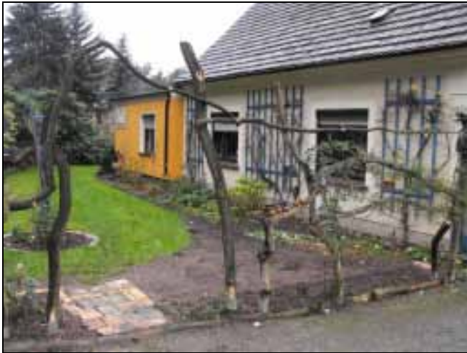
Die Umgestaltung des Vorgartens hat begonnen
